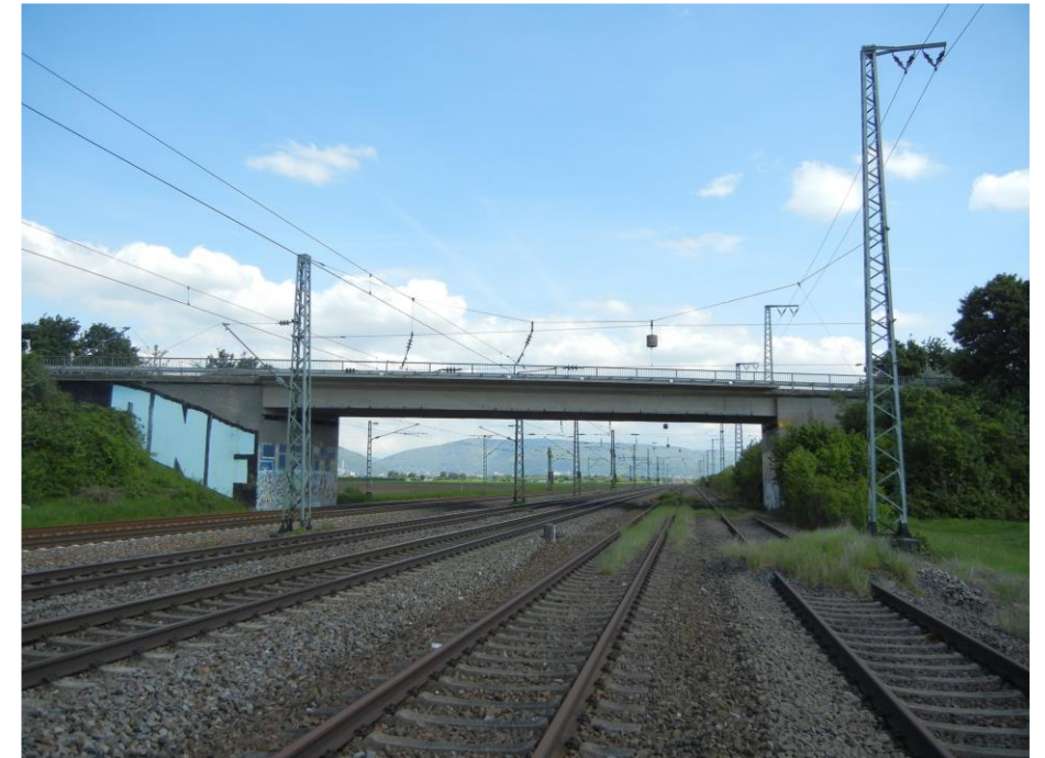
Grenzhöfer Straße – aktuelle Situation
