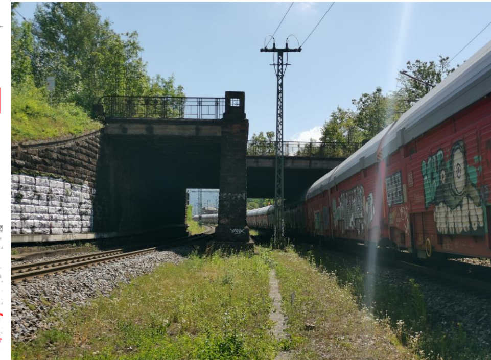
Stillgelegtes Kreuzungsbauwerk – aktuelle Situation
